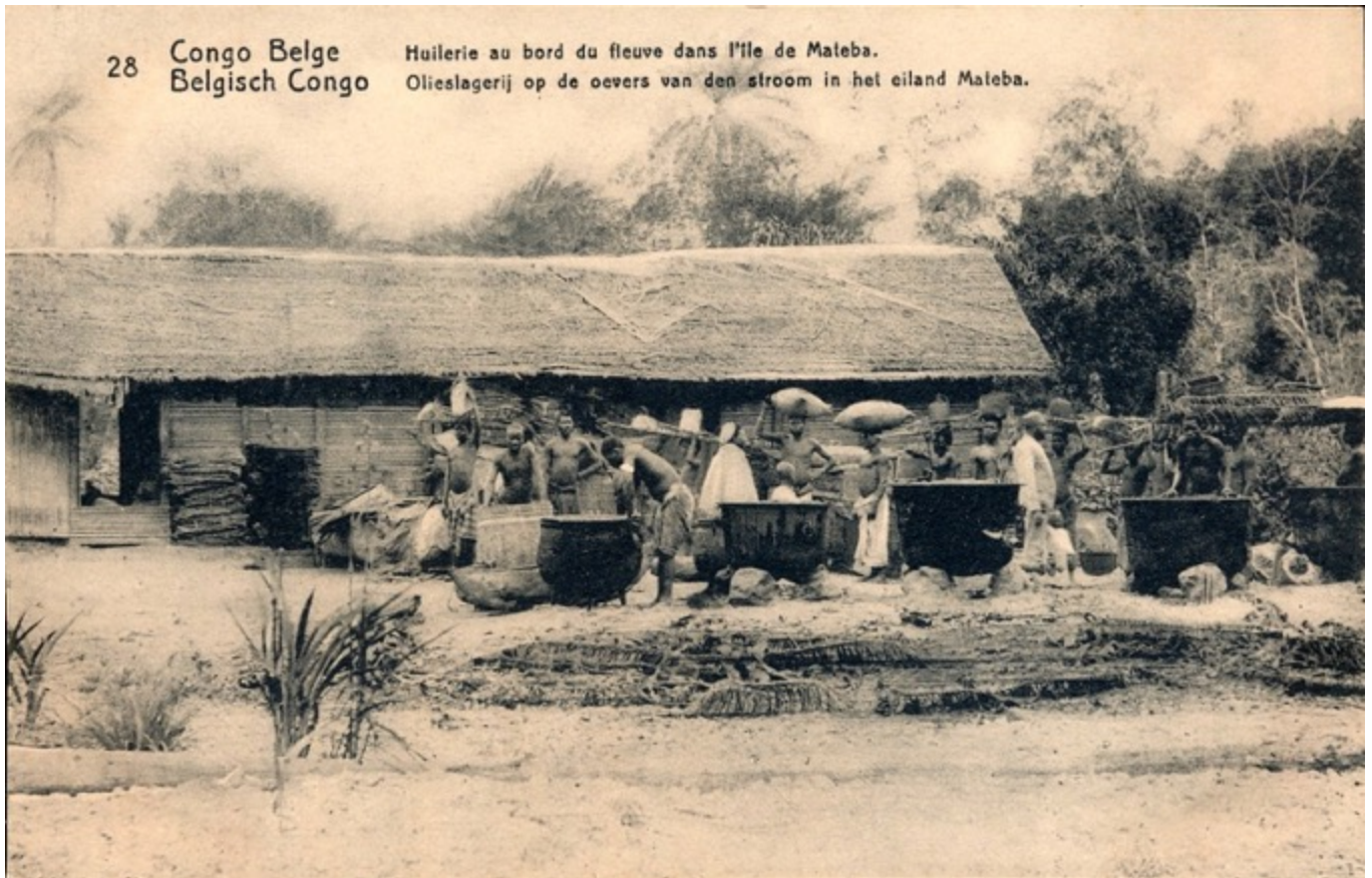
Op het eiland Mateba, dicht bij Boma ca 1918 In de ketels wordt de olie uit palm pitten gescheiden van de overige bestanddelen.
