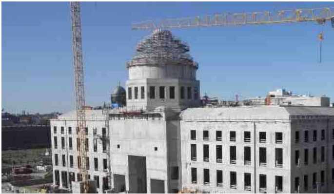
13. Het prestigieuze Humboldt Forum in aanbouw
